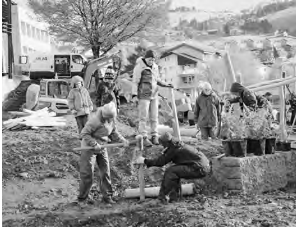
Bautag auf dem unteren Pausenplatz
